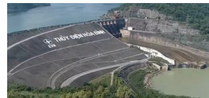
Hình 1.2. Nhà máy thủy điện Hoà Bình
