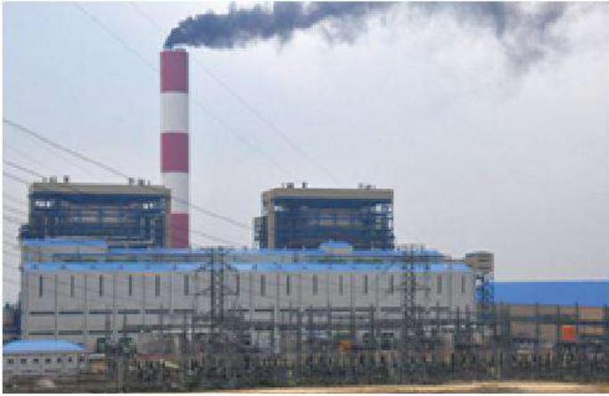
Hình 8.11. Nhà máy nhiệt điện đang thải khói ra môi trường
