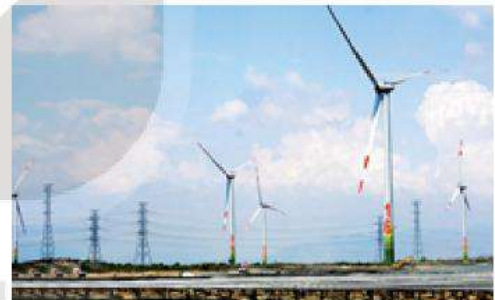
Hình 8.5. Trang trại điện gió Trung Nam, Ninh Thuận
