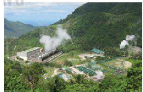
Hình 8.6. Dự án địa nhiệt tại Đak-rông, Quảng Trị
